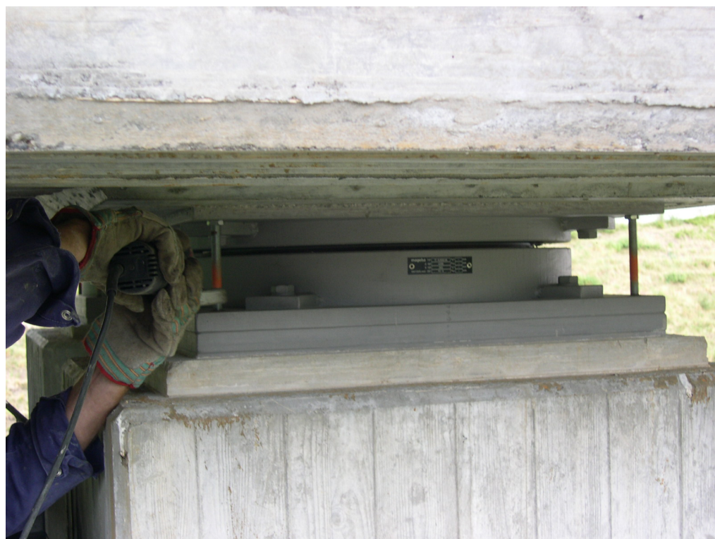
Partie 11 : Transport, entreposage intermédiaire et montage Démontage de la protection de transport immédiatement après le montage de l'appareil d'appui
